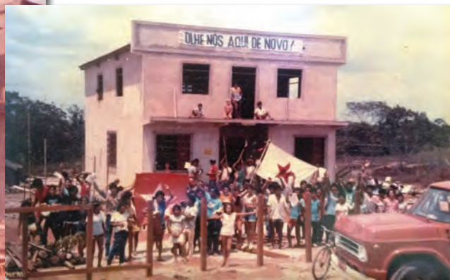
Reconstrução da sede do Sindicato dos Trabalhadores Rurais de Santarém, Pará, destruída por um incêndio criminoso em abril de 1985. Acervo: Sindicato dos Trabalhadores e Trabalhadoras Rurais de Santarém
